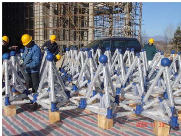
工程技术人员在兴隆观测站现场组装 MB 桁架
