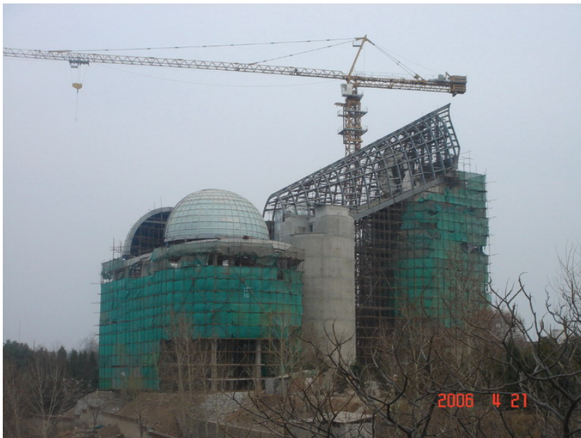
2006 年 4 月底的施工现场
